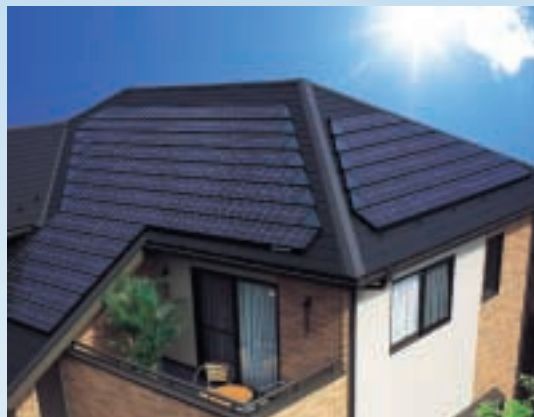
太陽の光エネルギーを電気エネルギーに変換する 住宅用太陽光発電システム
