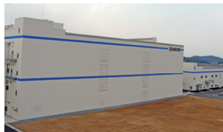
玉城工場 新トナー生産棟 (三重県)
