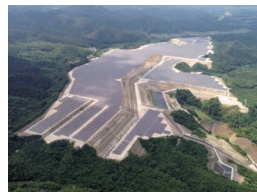
宮城・黒川 メガソーラー発電所
