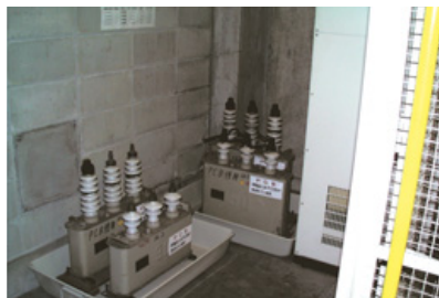
PCB廃棄物の保管状況
