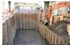
汚染土壌の除去対策
