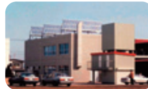
1991年北海道北見市に一般施設では国内初の系統連系システム (発電した電気を電力会社の電気系統と接続) を設置
