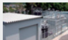
鉛リサイクル設備全景
