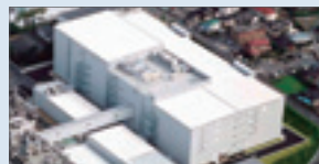
鹿児島国分工場 2-7、2-8、2-9工場
