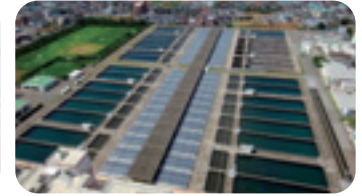
埼玉県 朝霞浄水場
