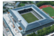
太陽光発電システム
