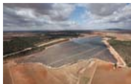
ドゥルシニア太陽光発電所
