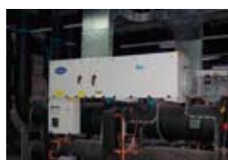
排熱回収型ヒートポンプチラー
