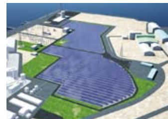
九州電力(株)様 約3MW供給 メガソーラー大牟田発電所
