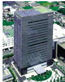
屋上と南側壁面に1,896枚の太陽電池モジュールを設置
