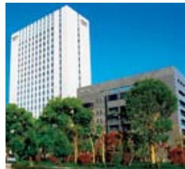
京セラミタ(株)の本社R&Dセンタービル
