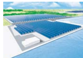
四国電力(株)様 約1.7MW供給 松山太陽光発電所
