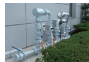
新設したガス配管
