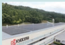
194KWの太陽光発電システムを増設(福島棚倉工場)
