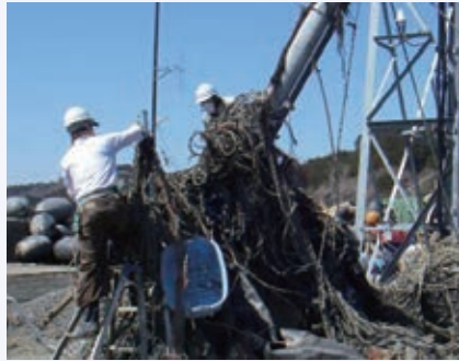
復旧作業の様子
