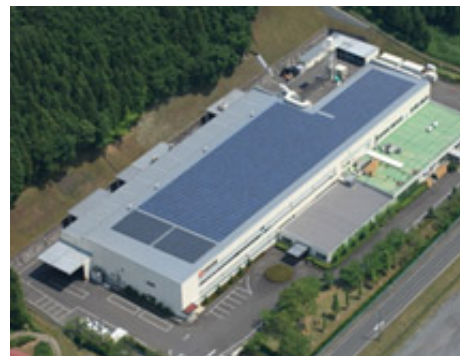
福島棚倉工場に設置の太陽光発電システム (230kW)
