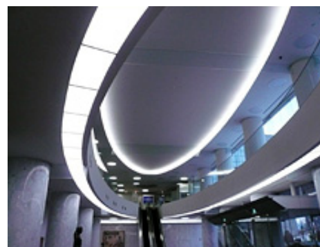
LED照明（京セラ本社）
