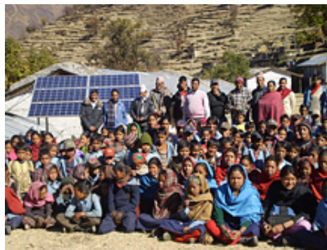
学校に設置された太陽電池 (ネパール)
