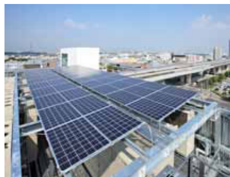
京都市成長産業創造センターの屋上
