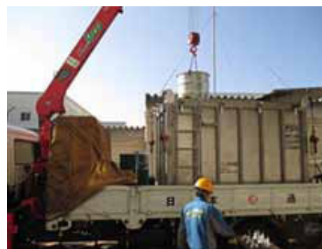
PCB搬出作業(鹿児島川内工場)
