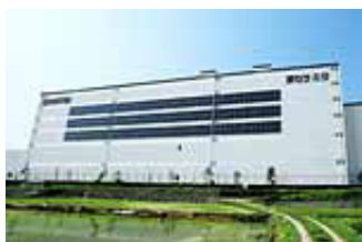
■ 京セラドキュメントソリューションズ (株) 枚方工場(60kW) (2005年度導入)
