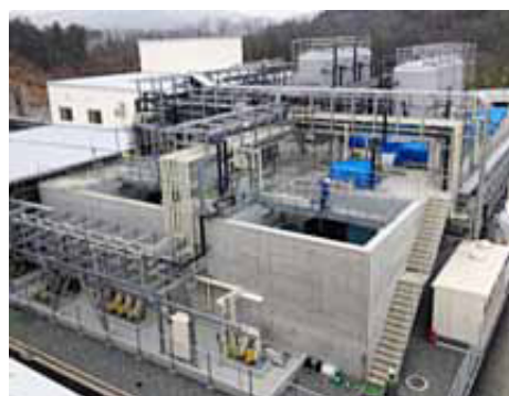
京セラSLCテクノロジー(株)京都綾部工場 に新設した排水処理場
