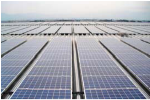
工場屋根に設置した太陽光発電システム (滋賀野洲工場)
