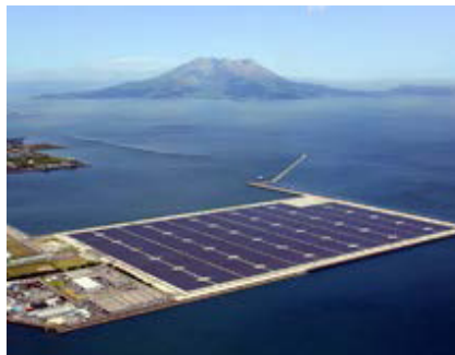
鹿児島七ツ島メガソーラー発電所
