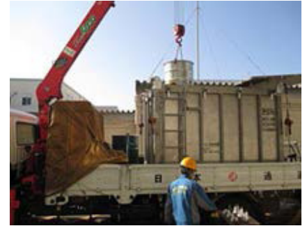
PCB廃棄物搬出作業(鹿児島川内工場)
