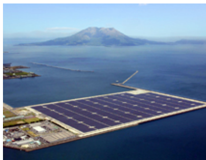
鹿児島七ツ島メガソーラー発電所
