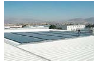
■ 京セラ(天津) 太陽エネルギー有限公司(中国) (93kW) (2010年度導入)
