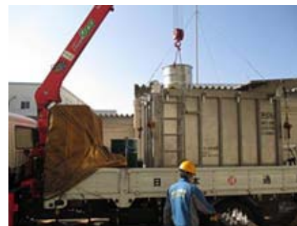
PCB廃棄物搬出作業（鹿児島川内工場）
