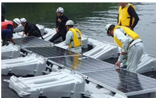
水上での設置作業の様子
