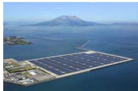
鹿児島七ツ島メガソーラー発電所 (鹿児島県鹿児島市、約70MW)
