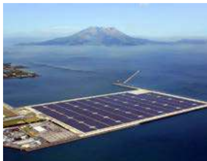
鹿児島七ツ島メガソーラー発電所
