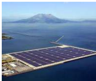
鹿児島七ツ島メガソーラー発電所
