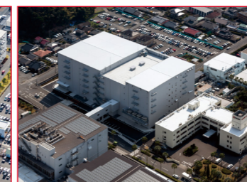
鹿児島国分工場 新工場棟
