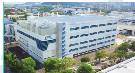
マレーシア:AVX マレーシア工場新工場棟
