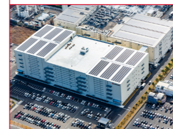
鹿児島川内工場 新工場棟
