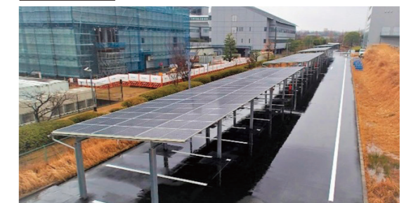
けいはんなリサーチセンターにおけるカーポートの設置
