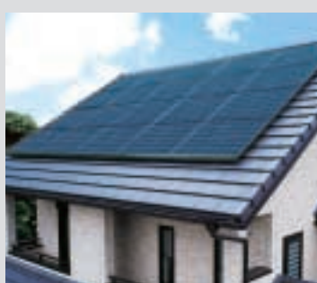
住宅用太陽光発電システム
