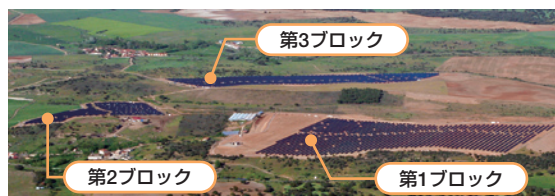
3ブロックからなる太陽光発電施設「プランタ・ソーラー・デ・サラマンカ」
