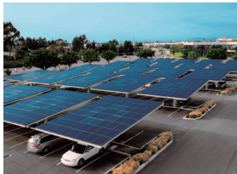
ソーラーパネル駐車場設置例
