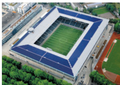
スイスのサッカー場に建設された 太陽光発電システム
