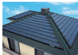
住宅用太陽光発電システム
