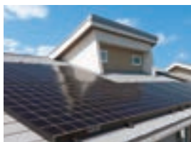
太陽光発電システム
