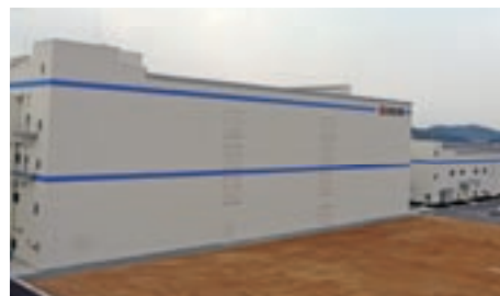
玉城工場 新トナー生産棟 (三重県)
