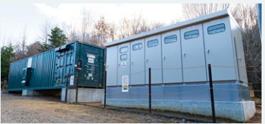
蓄電池、受変電設備、分散型サーバー設備
