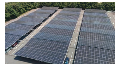
滋賀野洲工場におけるカーポートの設置
