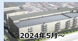
鹿児島国分工場 新棟
