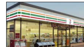
(株)セブンイレブン・ジャパン様 LED照明設置例
