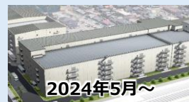
鹿児島国分工場 新棟
