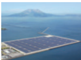
太陽光発電システム (鹿児島七ツ島メガソーラー発電所)
