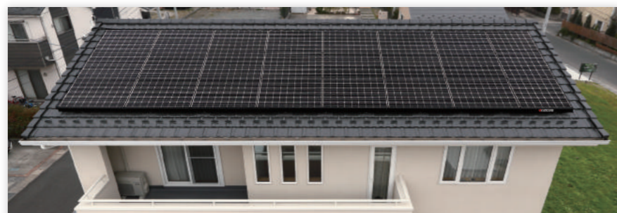
切妻屋根 / 平板瓦 ルーフレックス モジュール枚数: 24枚 (6.06kWシステム)
