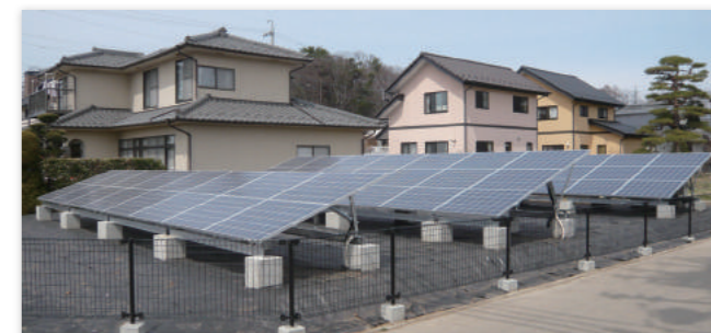
地上 エコノルーツ モジュール枚数: 55枚 (10.45kWシステム)
