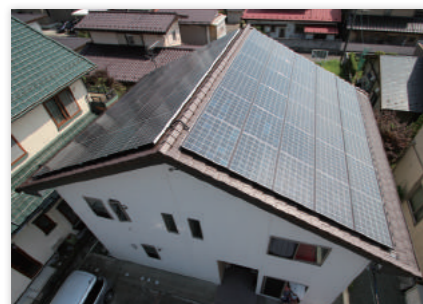
切妻屋根 / 平板瓦 エコノルーツ モジュール枚数: 60枚 (11.4kWシステム)
