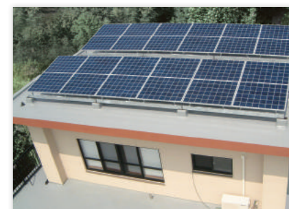
陸屋根 エコノルーツ モジュール枚数: 24枚 (4.32kWシステム)
