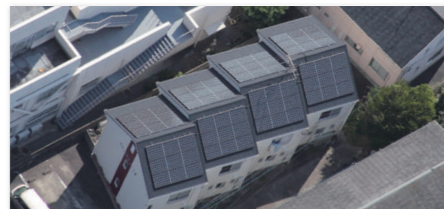
集合住宅 エコノルーツ モジュール枚数: 72枚 (12.60kWシステム)
