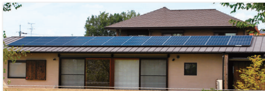
切妻屋根 / 縦葺き板金 エコノルーツ モジュール枚数: 36枚 (6.58kWシステム)
