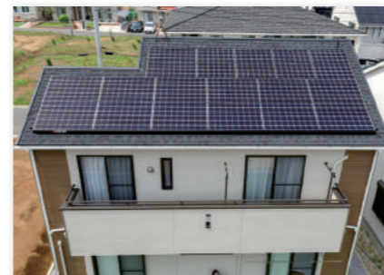
切妻屋根 / アスファルトシングル ルーフレックス モジュール枚数: 22枚 (4.50kWシステム)
