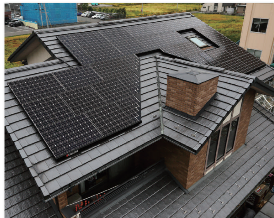
複合寄棟屋根 / 平板瓦 ルーフレックス モジュール枚数: 34枚 (7.00kWシステム)
