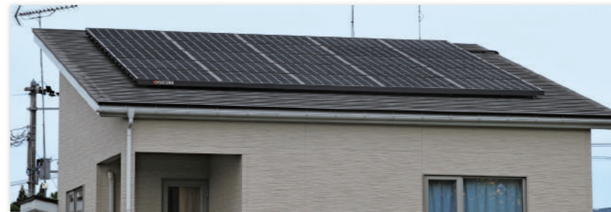
切妻屋根 / 横葺き板金 多雪地域専用システム モジュール枚数: 25枚 (5.25kWシステム)
