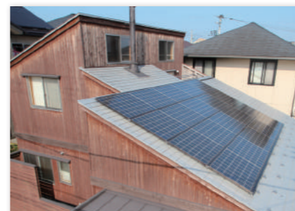
複合切妻屋根 / 横葺き板金 エコノルーツ モジュール枚数: 20枚 (3.72kWシステム)
