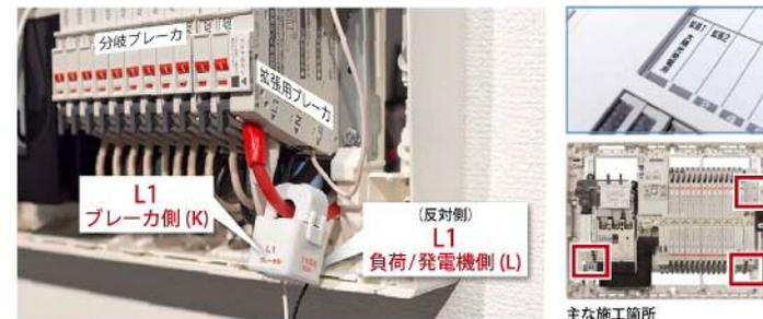
国内メーカー製の太陽光発電やガス発電用の機器、蓄電池などの多くは単相2線式ですのでL1の電線に取り付けてください。
