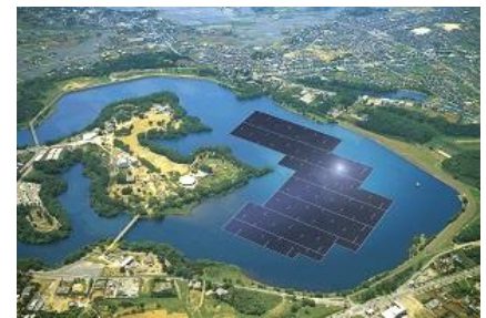
水上設置型太陽光発電システム
