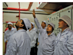
東南アジア地区での現場査察風景
