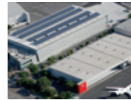
ボブ・ホープ空港 (米国) 268kW
