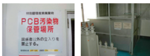
PCB廃棄物保管場所（長野岡谷工場）
